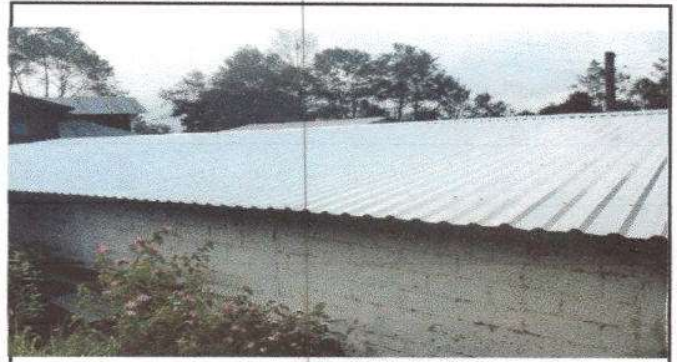
Foto 2: SUSTITUCION DE LAMINA POR LAMINA TROQUELADA ALUZINC, CALIBRE 26. UN TOTAL DE 209 M2
