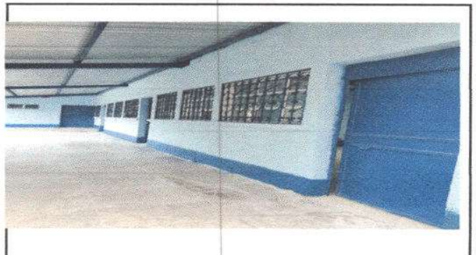
Foto 4: SUSTITUCIÓN DE ESTRUCTURA DE METAL DE VENTANA 11 M2 (8 VENTANAS DE 3 AULAS Y DIRECCIÓN)
