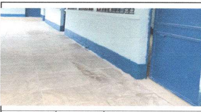
Foto 5: SUSTITUCIÓN DE PISO CERÁMICO UN TOTAL DE 171 m2 (3 AULAS, DIRECCIÓN Y PATIO)
