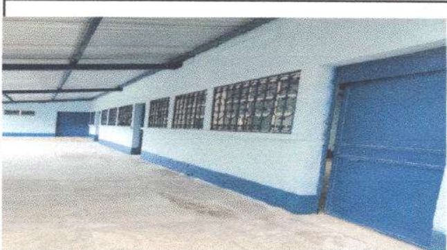
Foto1: PINTURA EN MUROS EXTERIORES E INTERIORES, 400 m2.
